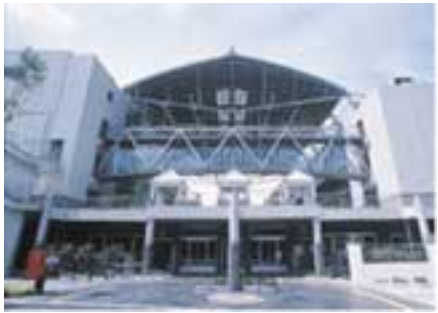
沖縄県総合福祉センターの正面写真です。立派な研修施設となっておりますので、お気軽にご利用下さい。
