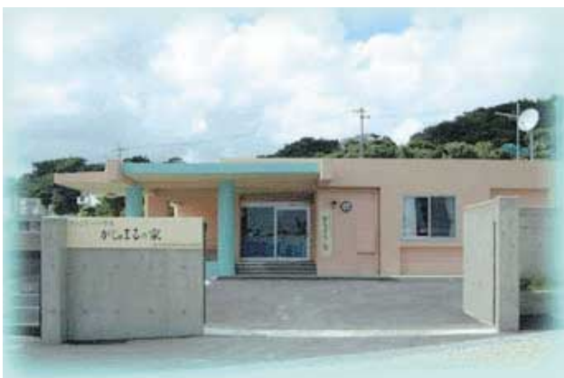
▲ガジュマルハウスの外観
